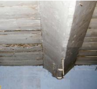
2010 : 1 e verdieping voorhuis Rotsenburg met de overlangs gehalveerde balken waarvan al in de jaren 1722-23 sprake is.
