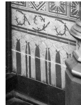
Catharinakerk, Utrecht verbouwing 1895 met restvoorraad Schillemans
