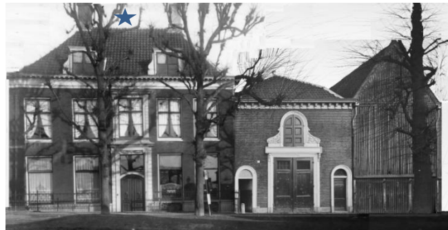
1936 UA 58100-58101 Helling 1-3 met rechts naast en achter het koets-huis een ruime houtopslag. Aan de overzijde langs de Vaart een 2 e opslag.
