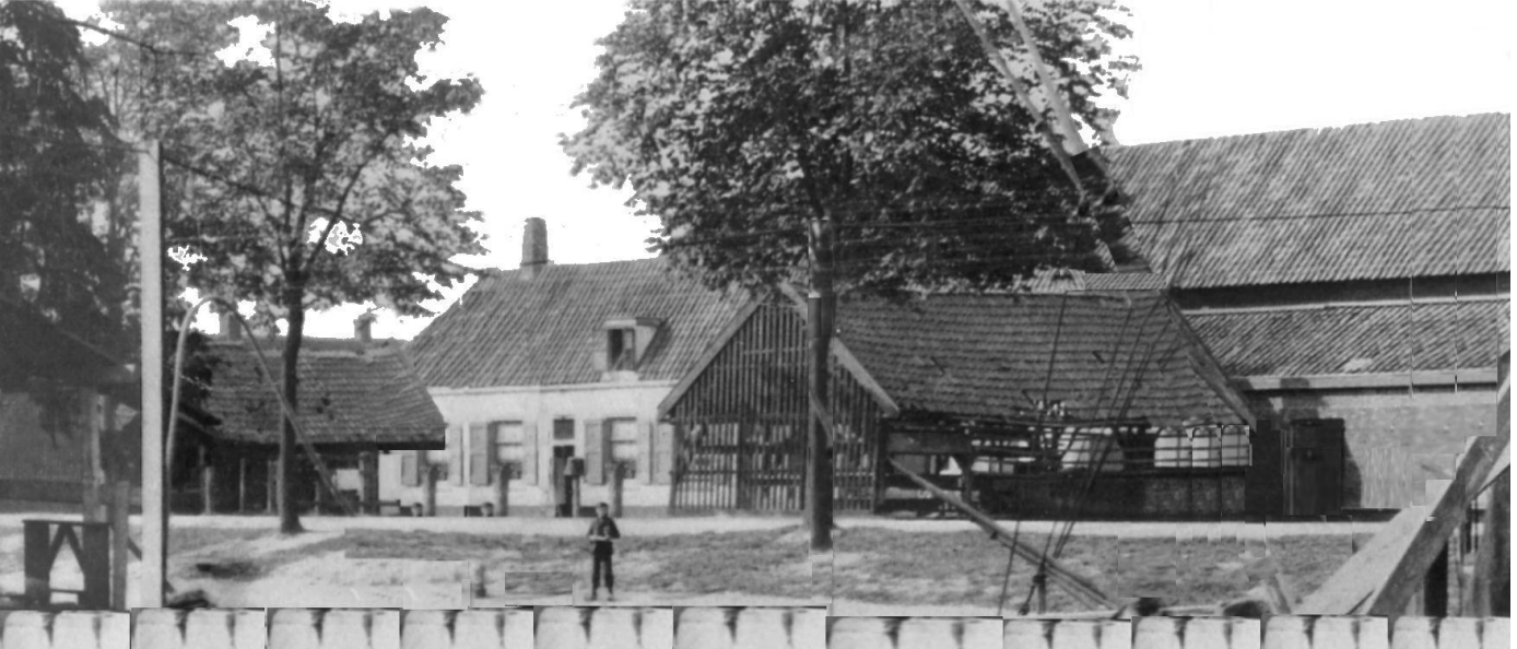
1907 Dakpanbakkerij De Heul, inmiddels gesloten, recht tegenover de in dat jaar gebouwde watertoren coll HKTH
