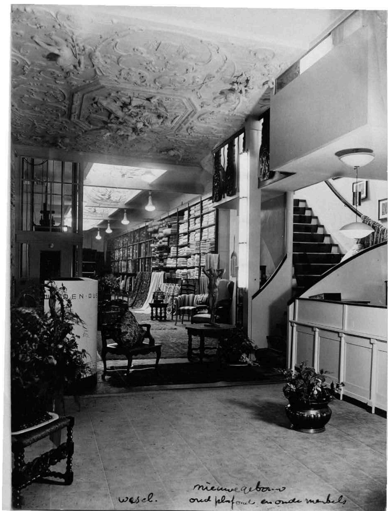
Das Einrichtungshaus Zaudy nach dem Umbau durch Rietveld im Jahre 1928, im Vordergrund die neue Warenausgabe und der neue Empfang mit Treppenhaus und Aufzug, im Hintergrund der schon
