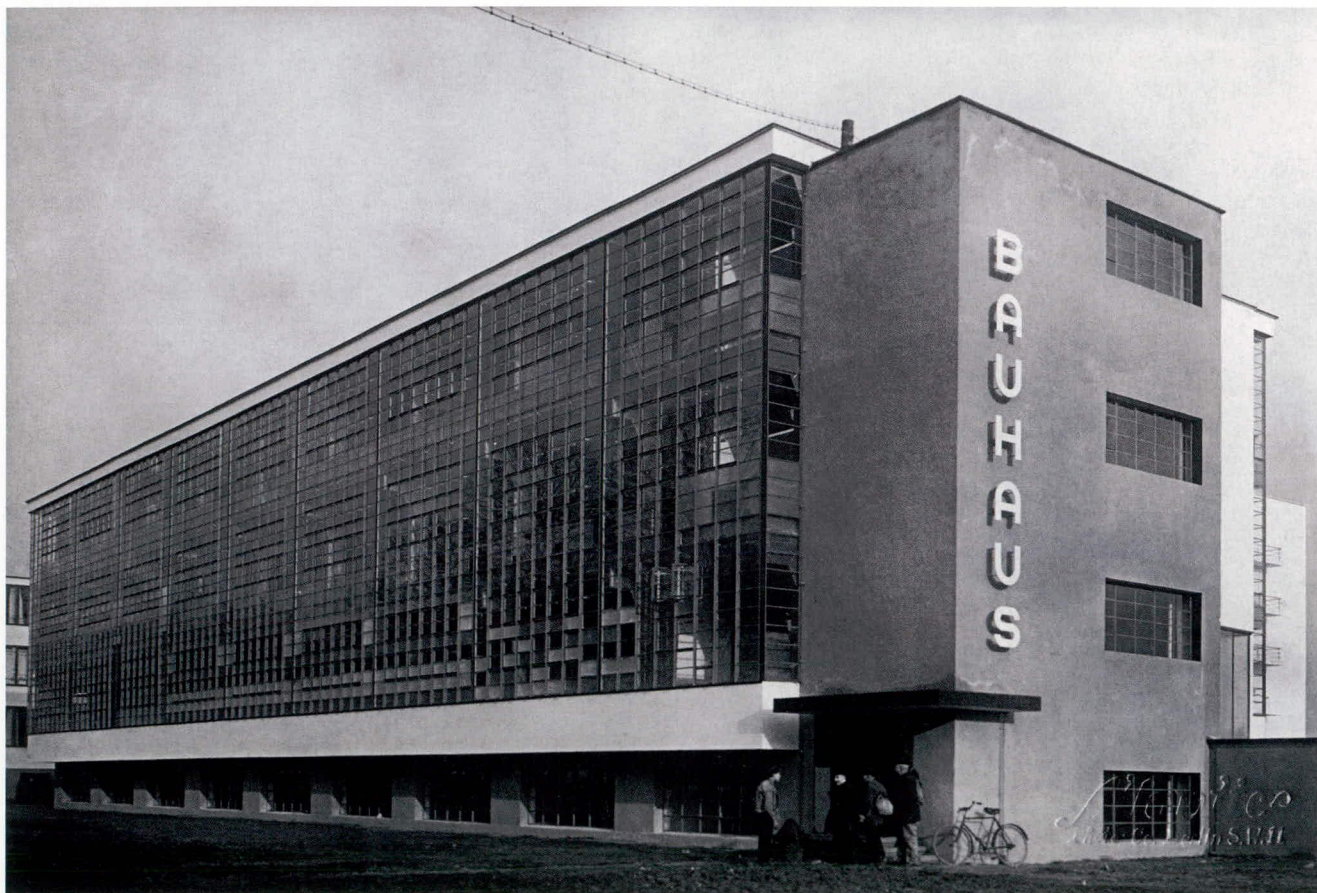
W. Gropius, Bauhaus, Dessau, 1925-1926 De glasgevel is een neutraal vlak dat gespannen is tussen een plint en een dakrand van een steenachtig materiaal. Bauhaus-Archiv, Berlijn
