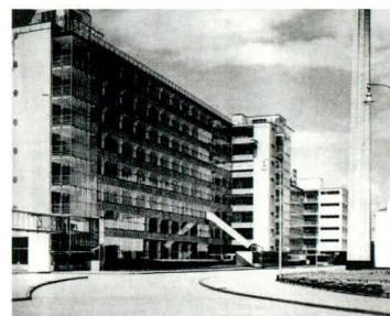
J.A. Brinkman en L.C. van der Vlugt m.m.v. M. Stam Van Nellefabriek, Rotterdam, 1925-1931 Ter plaatse van de borstwering zijn gesloten elementen toegepast en de dakrand is opvallend vormgegeven. NAI, Rotterdam
