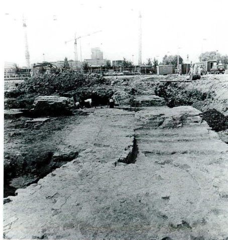
Afb. 11a: De massief dichtgemetselde gang in de noordelijke muur met een ronde ruimte voor een spiltrap. b: De dichtmetselingen zijn in de richting van de fausse-braye gegaan, waar ze in een staande tand eindigen en van waaruit de metselaars de muur kennelijk nog konden verlaten.
