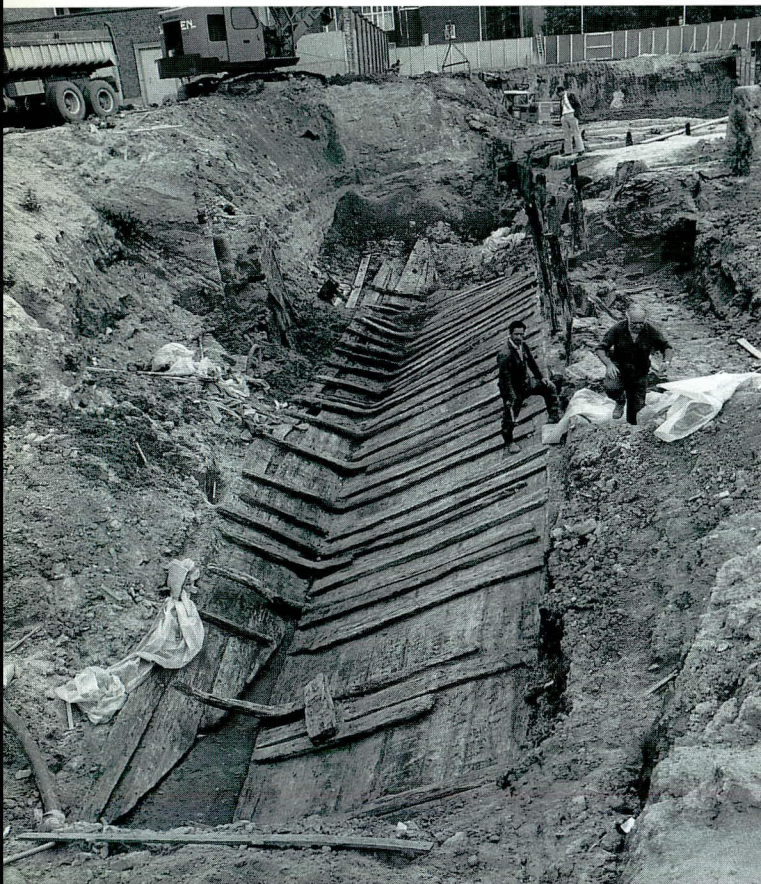
Afb.18 Het 'Utrechtse schip' van de Waterstraat. Dit zusterschip van het exemplaar in het Centraal Museum lag duidelijk beneden het grondwater, zoals aan de bronnering te zien is.
