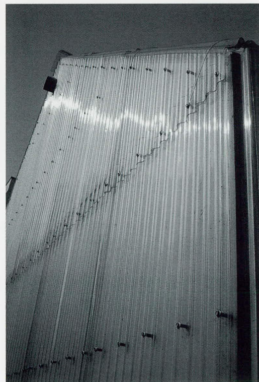
WOONHUIS MET PRAKTIJKRUIMTE, Herdersem België 1984-1988 Bekleed met doorzichtige golfplaten. HOUSE WITH SURGERY, Herdersem Belgium 1984-1988 Covered with transparent corrugated plastic.
