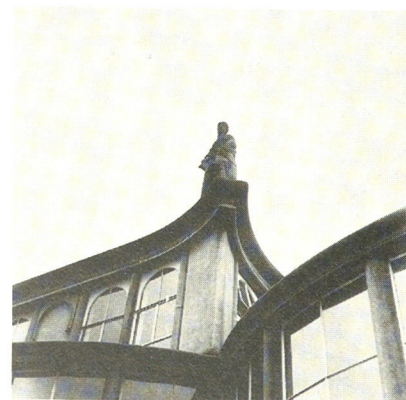
76 Utrecht, Centraal Station exterieur 1937 - 1940; cat.nr 80 Detail van de voorgevel met het beeld Veiligheid van Mari Andriessen: voorbeeld van silhouetwerking
