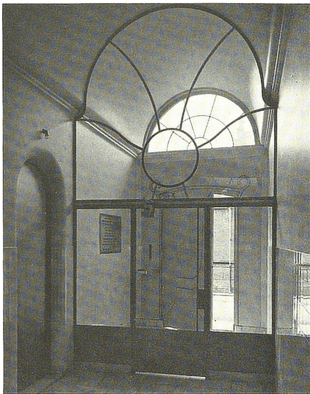
177 Utrecht, kantoor voor de 'Tiel-Utrecht', 1936; cat.nr 73 interieur hal; het bovenlicht boven de ingangsdeur en de deur zelf zijn oud, dat boven de glazen deur ontwerp Van Ravesteyn
